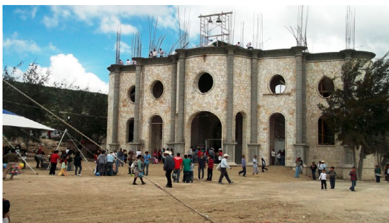
Imagen 4. Iglesia de San Cristóbal en construcción
