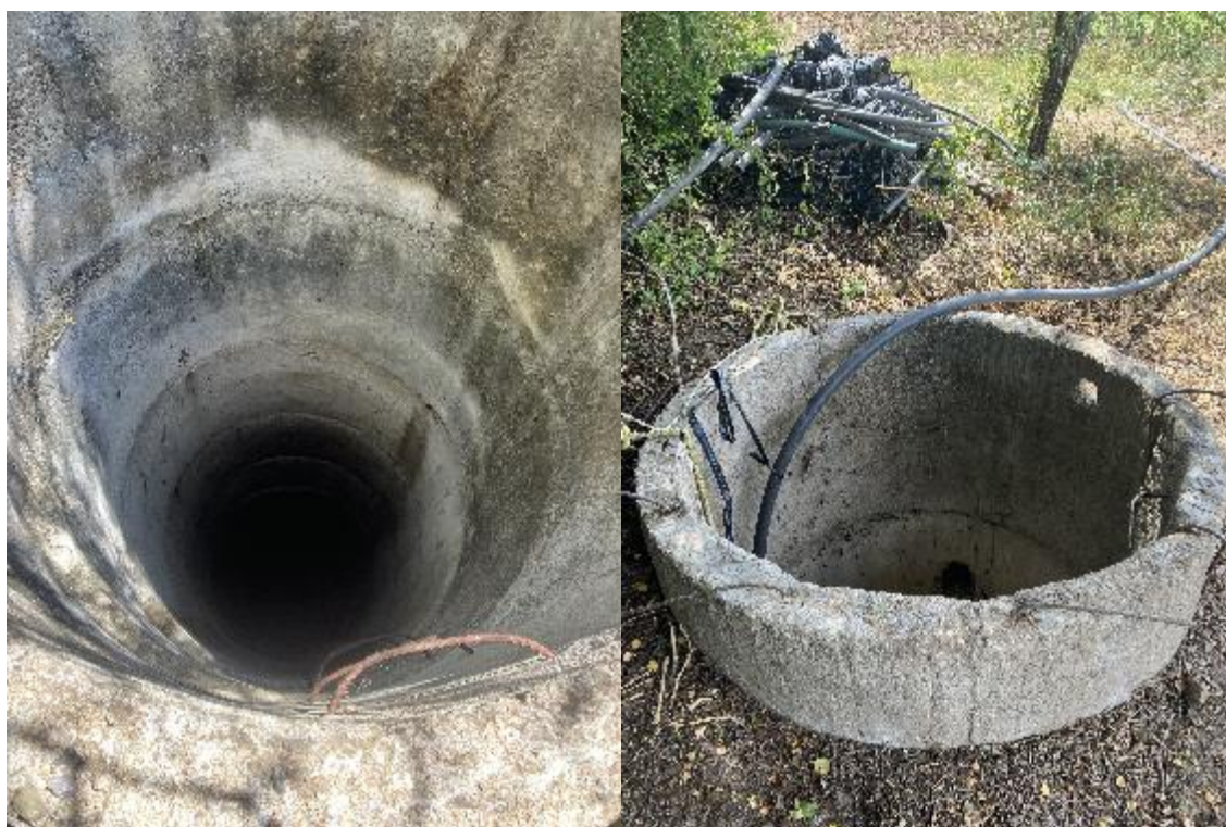
Figura 6.5 Pozo de agua en San Matías Chilazoa
